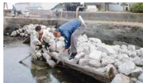
第1石積み遺構の調査のようす
