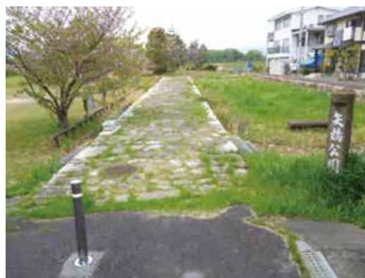
復元保存された矢橋港の船着き場
